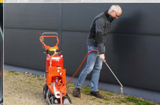
Mit dem Handbrenner können auch schwer zugängliche Stellen bearbeitet werden.
