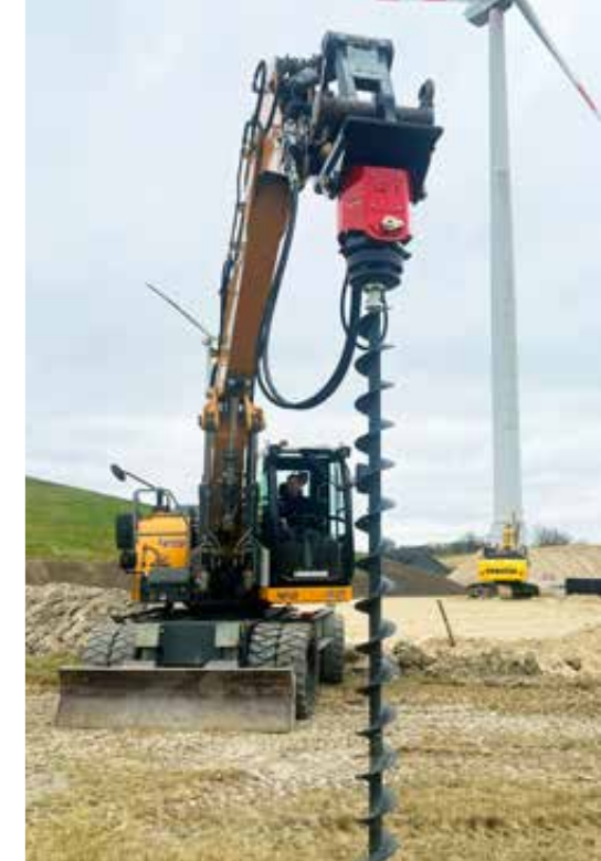
Le moteur de forage EHD en action avec une tarière sans fin pour la localisation des munitions non explosées
