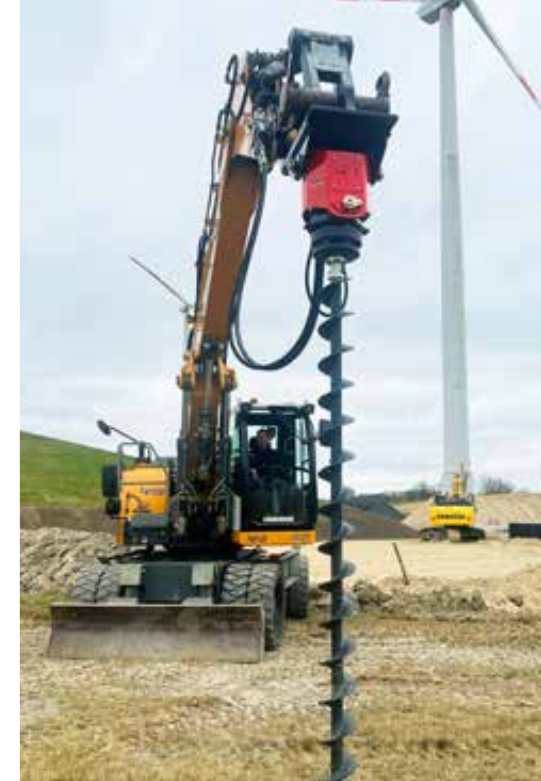
De EHD booraandrijving in gebruik met een avegaarboor voor explosievenopsporing
