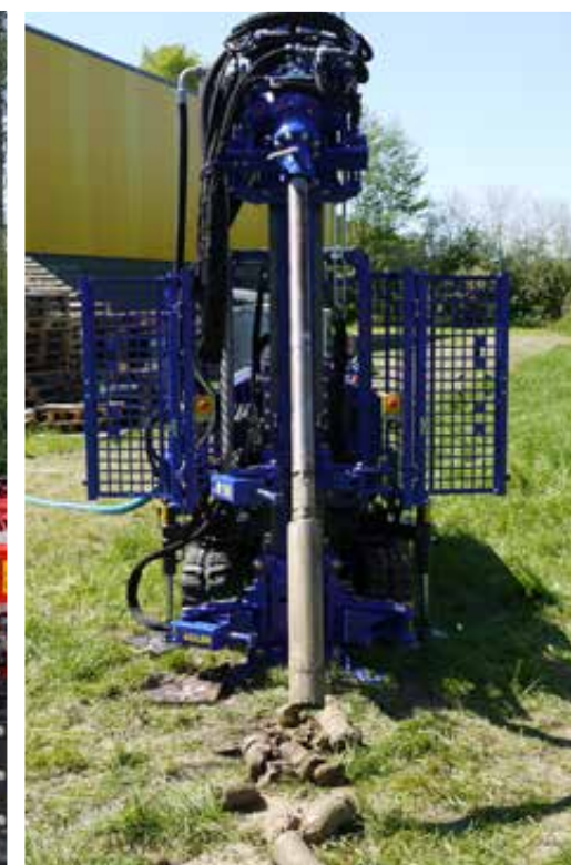
Kernbohrungen mit einem Einfachkernrohr oder mit Doppelkernrohr
