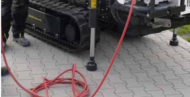
Luftkompressor – Antrieb über das Bohrgerät
