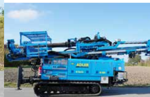
B 200 mit eingeklappter Bohrlafette im Verladezustand für den Transport zur Baustelle
