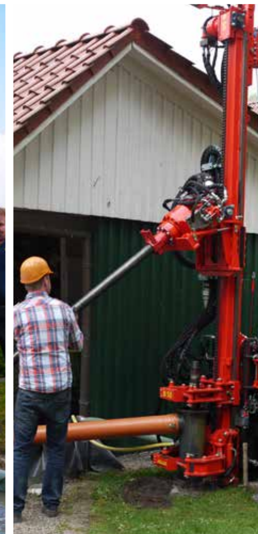
Gestängewechsel beim Spülbohrverfahren
