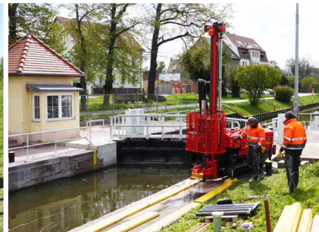
Kernbohrung an einer Kanalschleuse
