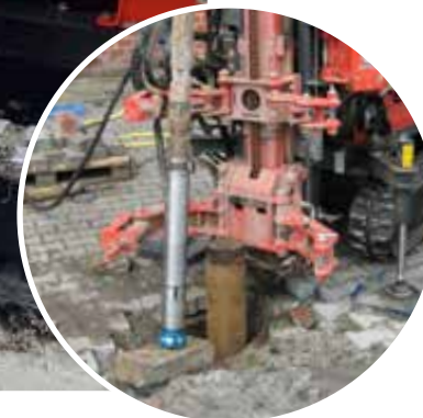
3" Imlochhammer mit Bohrkörone
