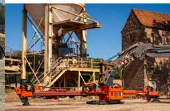
Aufstellen der Bohrlafette ABL mit dem Bagger
