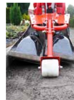
Ideaal om kanten te bewerken is de schuinverstelling van de stralers naar links of rechts
