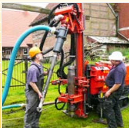
Perforación entubada con BOP (dispositivo preventor)
