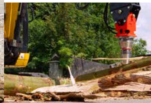
Effektives Arbeiten selbst bei kleineren Baggern
