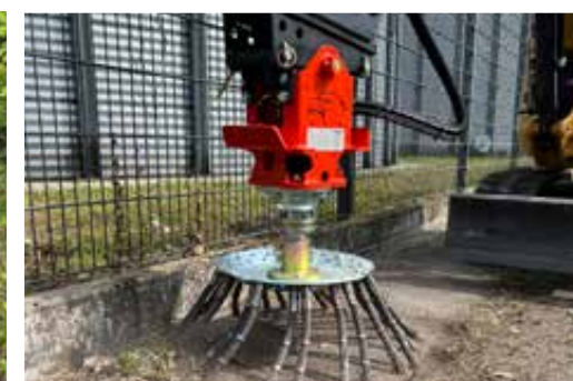
Steigerung der Flächenleistung durch Verschwenken des Baggers
