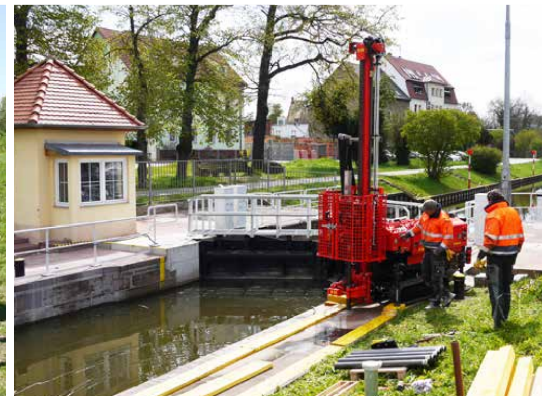
Kernbohrung an einer Kanalschleuse
