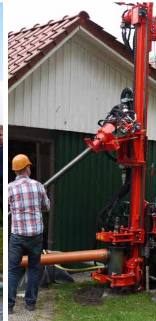
Gestängewechsel beim Spülbohrverfahren
