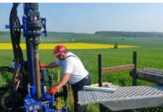
Borgerät B 25 im Einsatz beim Kerne ziehen
