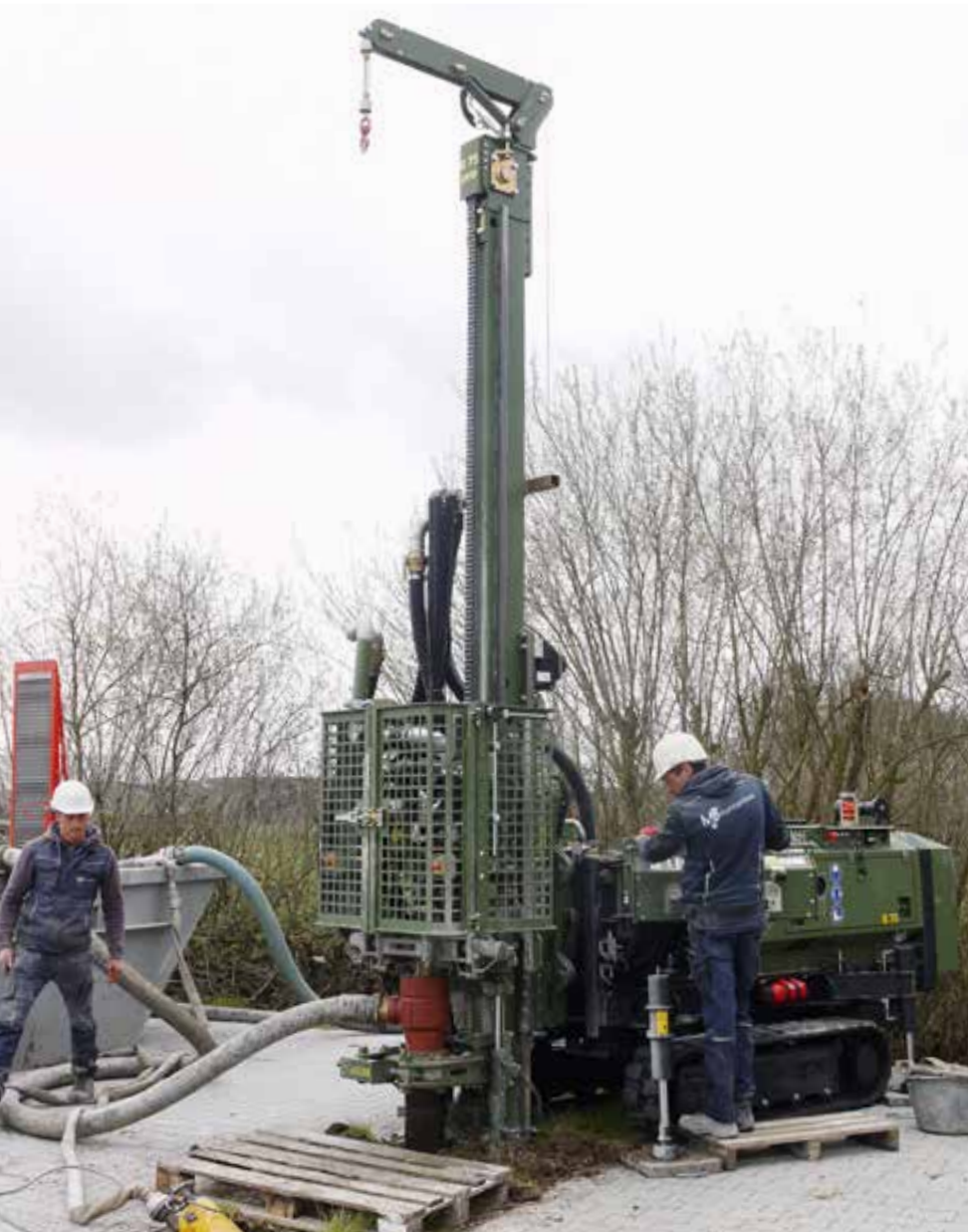
Spülbohren mit einem Wasserkreislauf über einen Container
