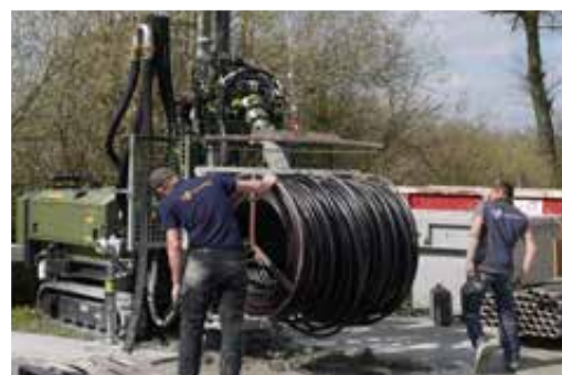
Einbauen einer Erdwärmesonde
