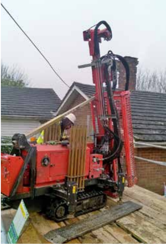
Sondierbohrung zum Orten von Hohlräumen
