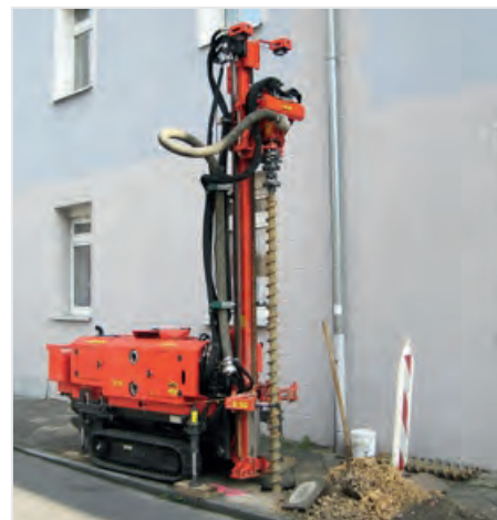
Wiercenie w mieście z wykorzystaniem ślimaka
