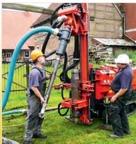
Wiercenie z orurowaniem z głowicą ochronną z odpływem bocznym
