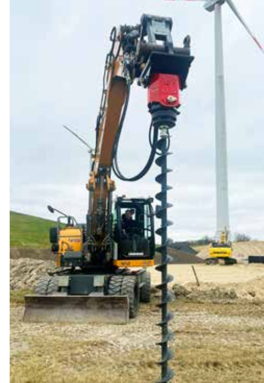
Der EHD Bohrantrieb im Einsatz mit einer Endlosbohrschnecke für die Kampfmittelsondierung
