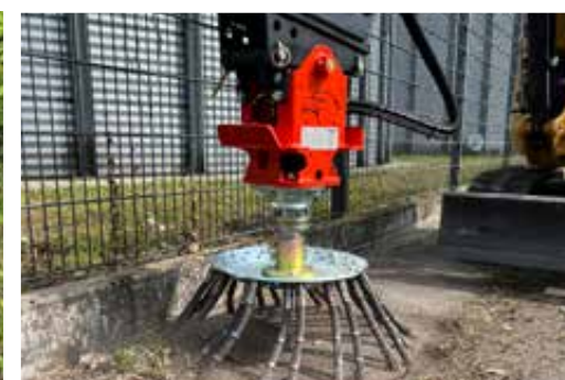
Steigerung der Flächenleistung durch Verschwenken des Baggers
