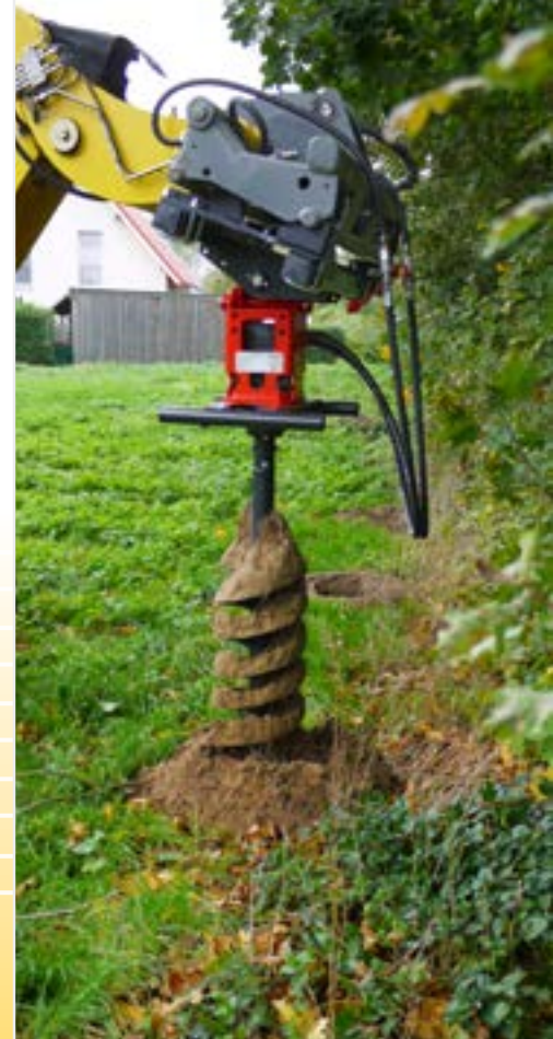
Erdbohrer im Einsatz am Radlader
