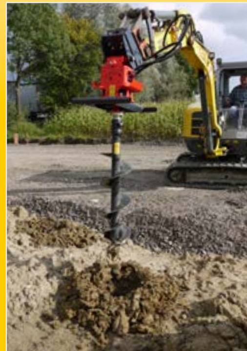
Erdbohrer am Minibagger
